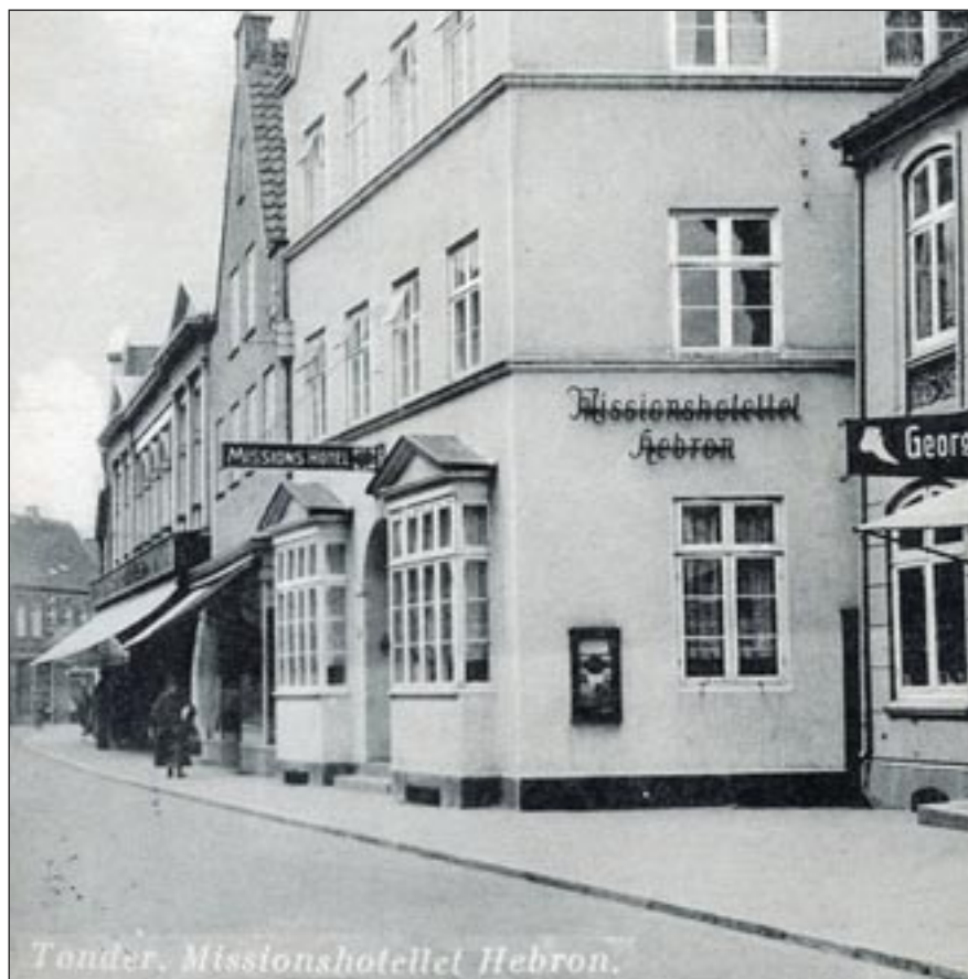
Tønder, Missionshotellet Hebron. Missionshotellet i 1925 efter den store ombygning, der udover en etage mere forsynede huset med to karnapper.
